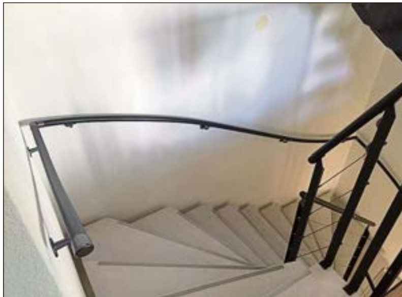
Wandhandlauf an der Breitseite der Stufen. Unzureichendes Geländer: auf der Wandseite nachgerüstet.
